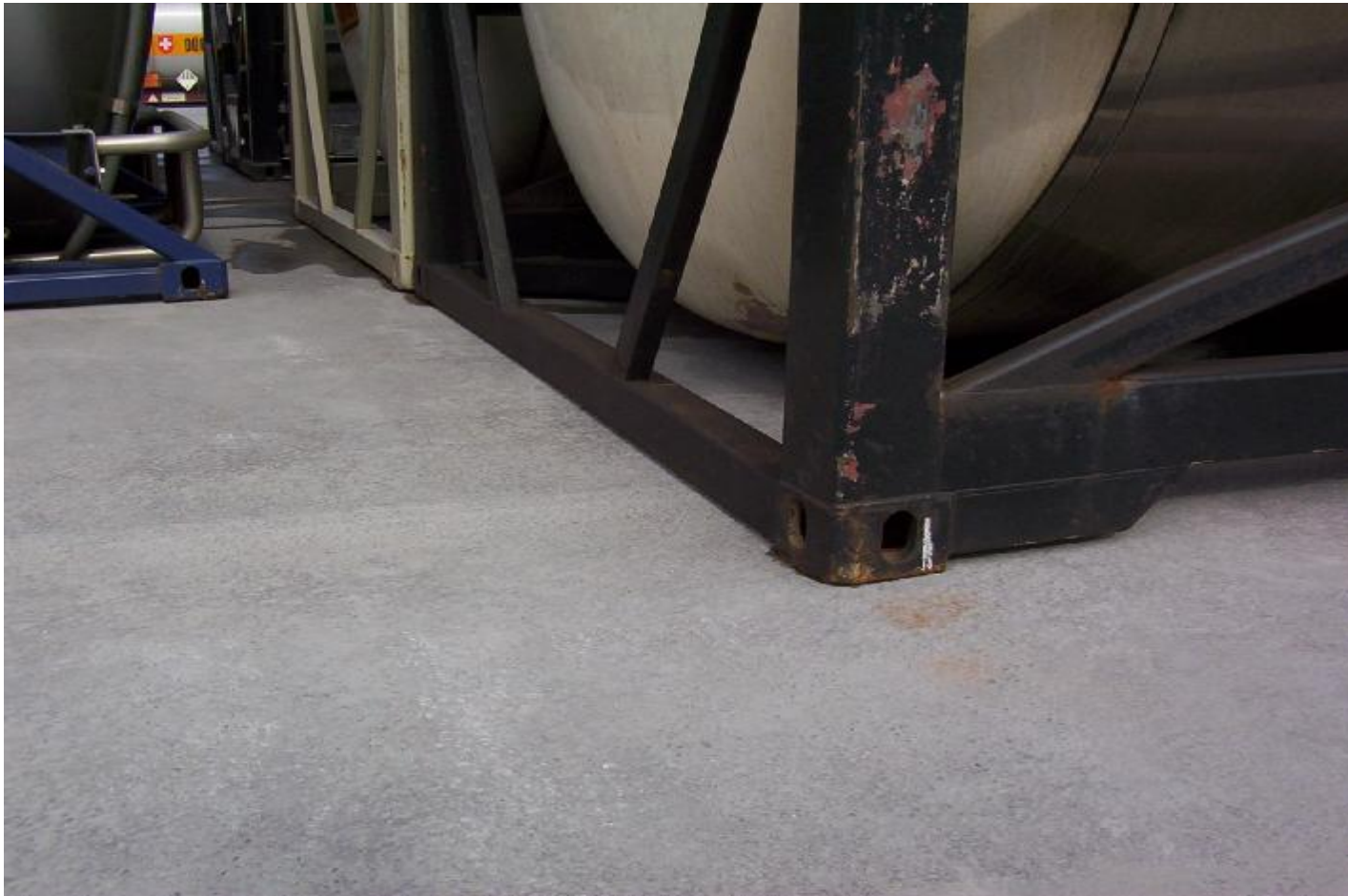
Brunsbüttel, Elbehafen - Containerstellfläche
