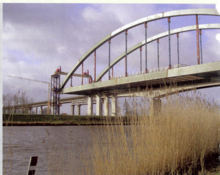
Die Stahlbrücke wurde auf Pontons bei Hochwasser über die Stör geschoben.
