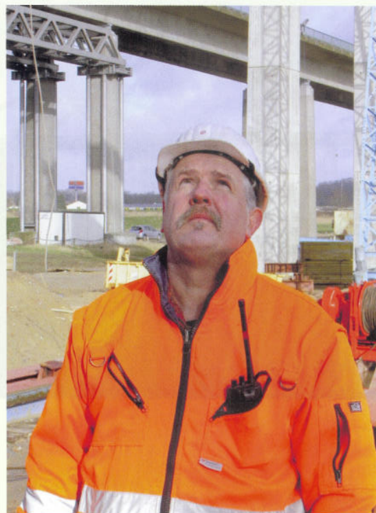
Bauleiter Uwe Hartmann hatte die Montage der Brücke stets im Blick.
