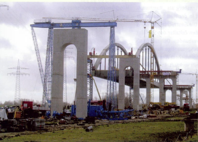
Die Strombrücke wird langsam auf die erforderliche Einbauhöhe gehoben.
